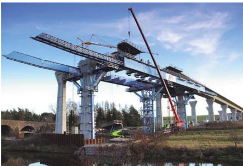
Рис. 23. Мост *Brücke über die Zwickauer Mulde* на автобанае 72, передвижные подмости
