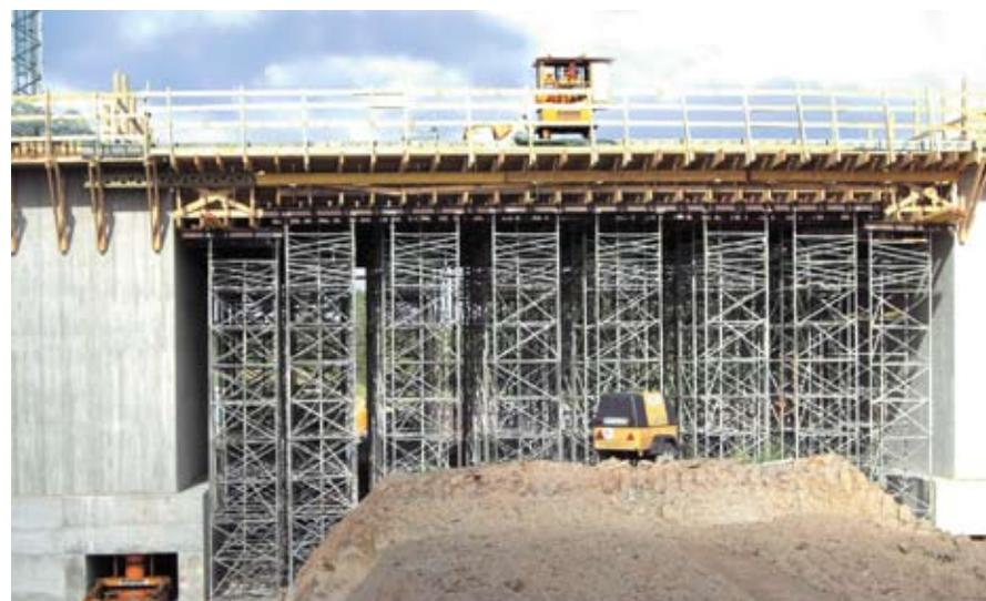
Рис. 2. Сооружение опалубки на сплошных подмостях на естественном основании
