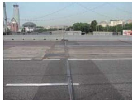
модификаций разработаны и изготавливаются в Швейцарии фирмой Proseq. Они имеют резиновый профиль, плотно вставленный в стальные угловые направляющие, которые изготовлены методом экструзионного прессования.
