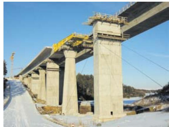
**Рис. 20. Мост с переменным поперечным сечением пролетного строения и вспомогательными временными опорами. Длина пролета 80 метров**
