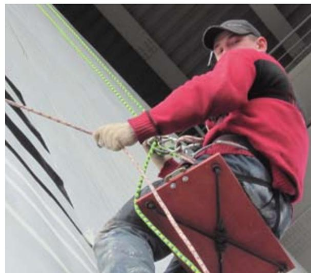
На ЗСД мы используем покрытия International. Они разработаны по новейшей, нецинкосоудержающей схеме, первые два слоя — эпоксиэпоксиды, физически закрепляющие металл. Последний слой — полиуретан, устойчивый к температурным колебаниям и УФ-излучению. Прекрасные краски выпускают такие известные на рынке производители, как Hempel, Jotun, Tambor, Виникор, Вилконсон и др.
