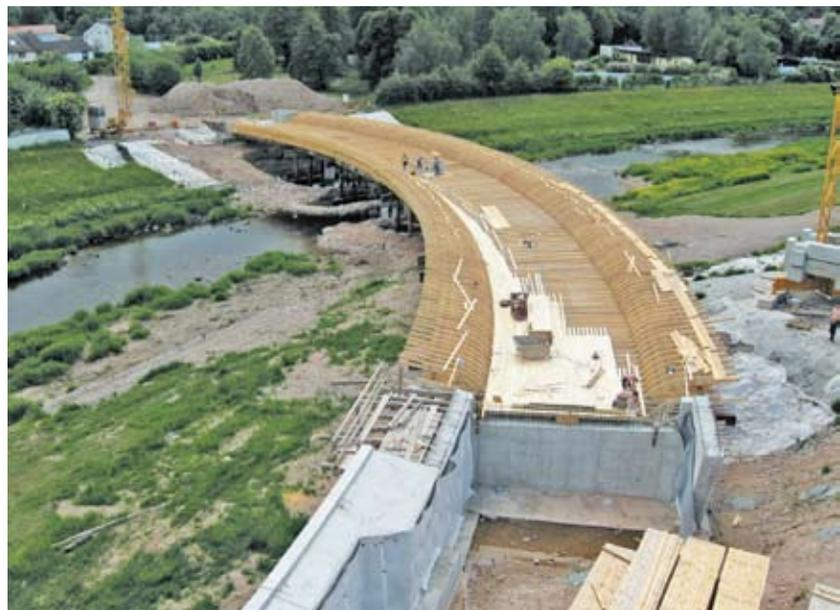
**Рис. 6. Сооружение опалубки на тяжелых подмостях**
