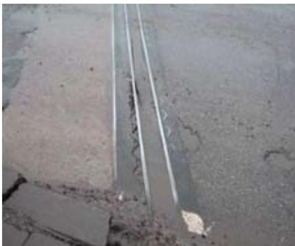
Sealants (Великобритания). Основной конструктивный элемент шва VEJ — резиновый компенсатор сложного профиля многоячеистой структуры, непрерывный по длине шва. Компенсатор вставляется в пазы соответствующего очертания, которыми оснащены металлические окаймления, заделываемые в специальные вставки из синтетических смол, которые сопрягают их с асфальтобетоном покрытия.
