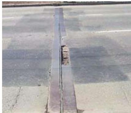
ления в виде двух уголков размером 125×125×12 мм с ребрами жесткости, опорных пластин с отверстиями, прикрепленных к плите пролетного строения болтами и забетонированных с приваренными хомутами на подходах, а также резинометаллического заполнения, состоящего из металлических креплений и резинового неразрезного по длине шва компенсатора.
