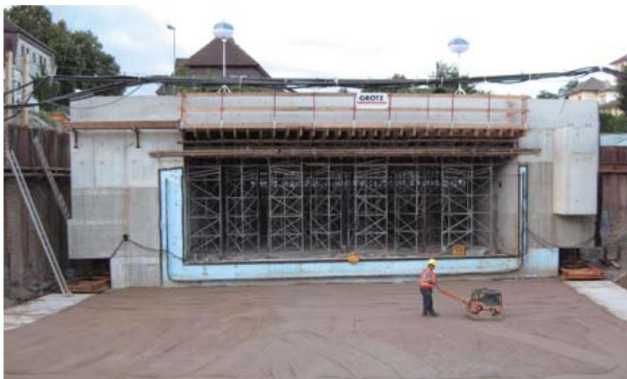
Рис. 3. Сооружение опалубки на сплошных подмостях, опирающихся на ж/б плиту рамной конструкции моста
