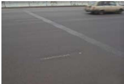
перемещениях до 50 мм. Оптимальное — до 40 мм. За счет использования высококачественного связующего материала ВJ 200, укладываемого на месте, обеспечивается однородность езды по проезжей части. Деформации сопрягаемых конструкций компенсируются деформациями упомянутого связующего материала совместно с гранитным каркасом, где используется кубовидный щебень.
