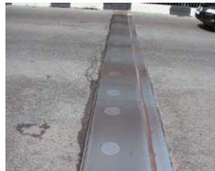
перекрывающего зазор, конструкции обеспечивают перемещения до 300 мм.
