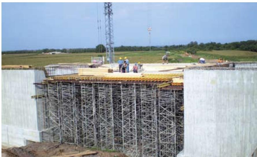
Рис. 1. Сооружение опалубки на сплошных подмостях на естественном основании
