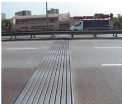
новым элементом, 160 мм — уже с двумя. Для больших перемещений применяют конструкции деформационных швов модульного типа.
