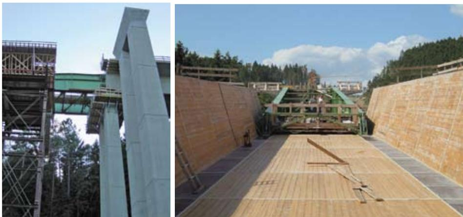
**Рис. 25, 26. Мост Judental на автобане 71, завод аванбека в опалубку на стапеле**
