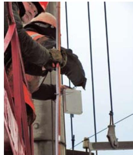
**Рис. 6. Установка системы непрерывного мониторинга контактной сети в опытную эксплуатацию**
