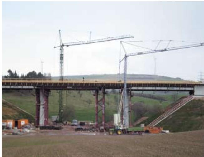
**Рис. 8. Тяжелые подмости с опалубкой пролетного строения**
