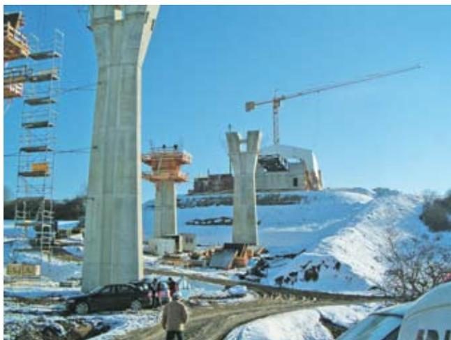
**Рис. 15. Применение тепляка для сооружения в зимнее время**
