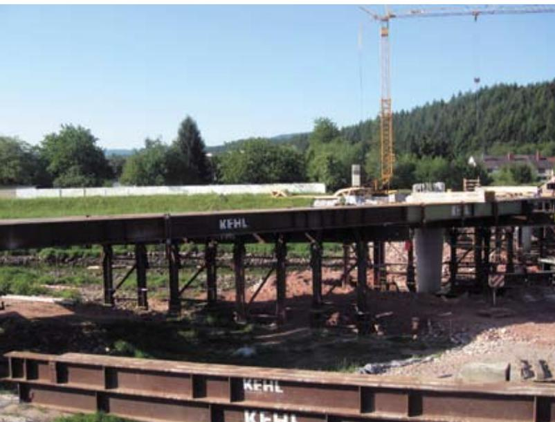
**Рис. 5. Сооружение тяжелых подмостей**
