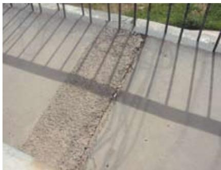
— из комплексного органического вяжущего (КОВ-65) со щебеночным наполнителем (каркасом), способным воспринимать перемещения от
