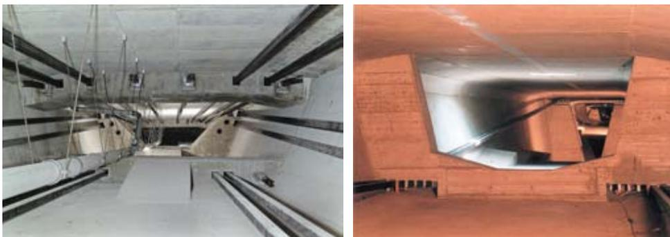
**Рис. 28, 29. Примеры установки пучков наружного натяжения**
