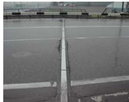
технологии холодной вулканизации. Блоки деформационного шва крепятся к мостовым конструкциям с помощью шпилек, шайб и гаек в ранее просверленные отверстия, в которые опущены стеклянные капсулы с эпоксидно-полимерным компаундом.
