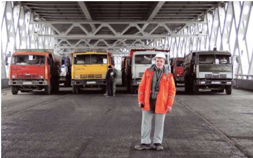
Испытания статическими нагрузками на ЗСД
