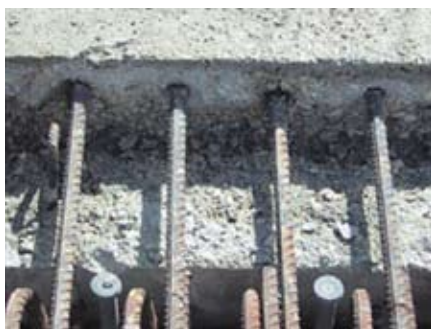
Рис. 4.8. Стык плиты на обработанном участке
