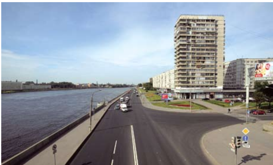
Октябрьская набережная после текущего ремонта
