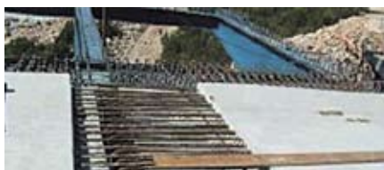
Рис. 4.9. Стык арматуры на участке омоноличивания
