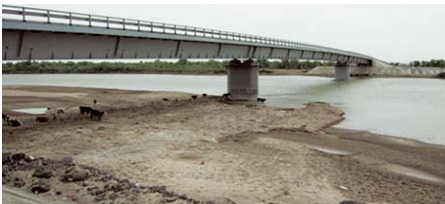
Мост через реку Сырдарья в районе поселка Жанакорган (Казахстан)
