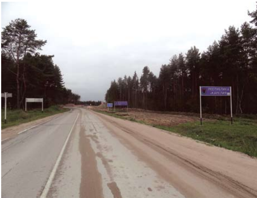
Участок автомобильной дороги А-121 «Сортавала»
