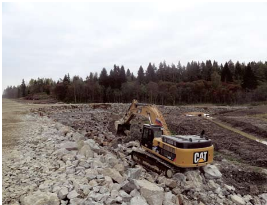
Работы ведет ЗАО «ВАД»
