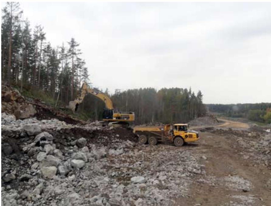
Строительные работы на участке км 155 – км 173 дороги А-121 «Сортавала»
