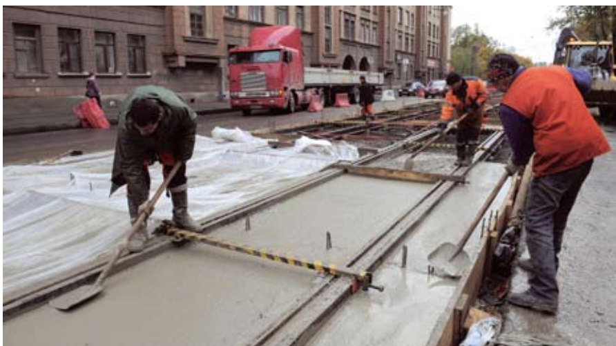
Ремонт трамвайных путей по новой технологии
