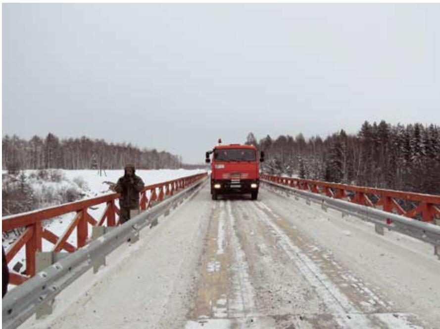
Приемочные испытания моста через реку Мокуя
