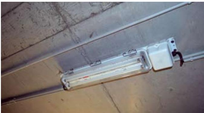
**Рис. 5. Светильник системы аварийно-эвакуационного освещения**
