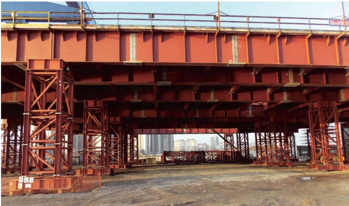
блоков является отличительной чертой практически всего проекта. Это позволяет значительно повысить качество монтажа, а также сократить продолжительность монтажных работ. Но выполнение этих работ требует высокотехнологичного оборудования.
