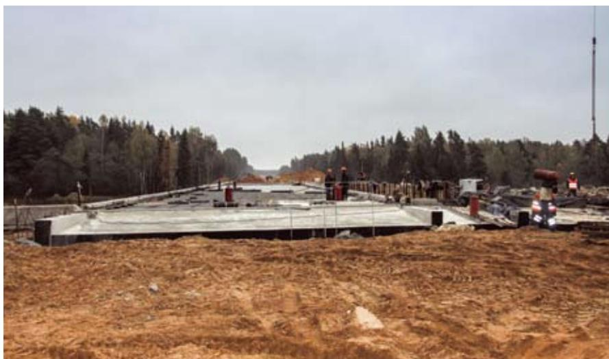
грунта на песчаный и армированию геотекстилем. На болоте третьего типа в районе реки Чамки специалисты ООО «Трансстроймеханизация», прежде чем производить отсыпку земляного полотна, занимались сооружением свайных полей с устройством гибкого ростверка.
