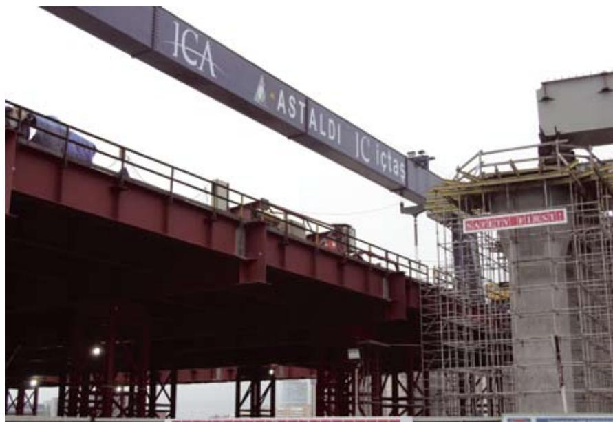
подъема блоков пролетного строения с плавучих средств в русловой пролет.
