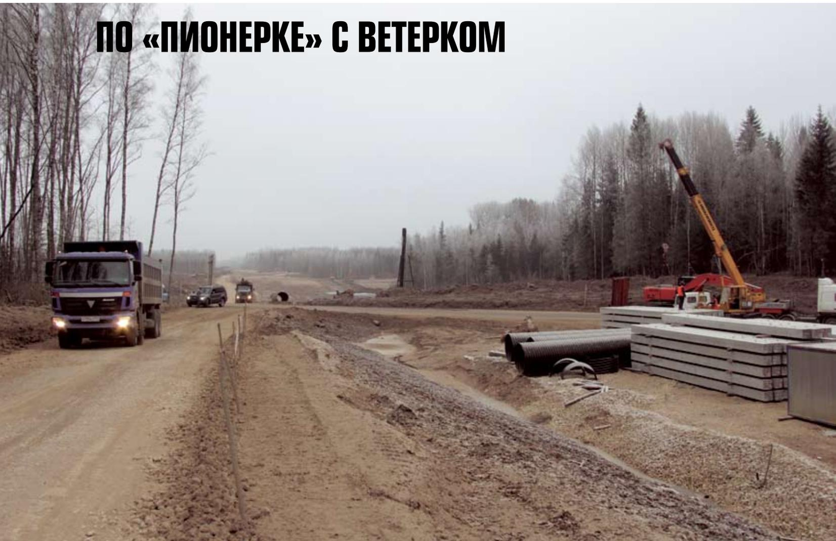
**М**ы сворачиваем на «пионерку» — техническую дорогу, которая идет вдоль строящейся трассы на всем ее протяжении.
