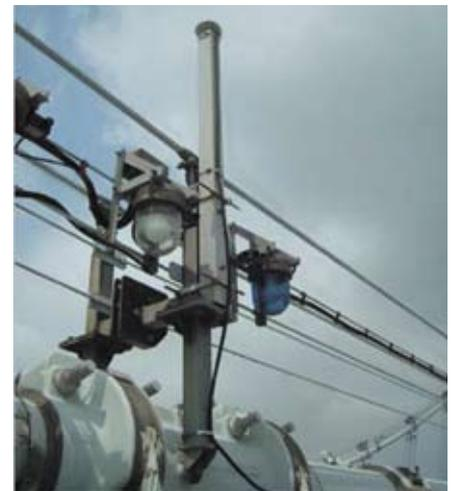
Станция спутникового мониторинга висячего моста Tsing Ma в Китае
