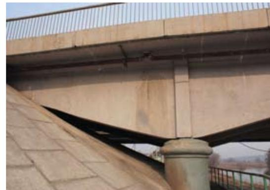
Фото 5. Мост через реку Протва. Состояние после 7-ми летней эксплуатации. 2010 год
