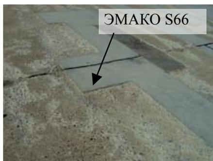
Фото 2. Рулежная дорожка а/п «Пулково» через 10 лет после ремонта. Шелушение неотреставрированного бетона — результат отсутствия вторичной защиты.
