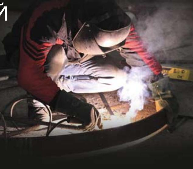
Сборка и сварка монтажных соединений стальной балки жесткости руслового пролетного строения моста через пролив Босфор Восточный на остров Русский будет выполняться по специальному технологическому регламенту, который разработан нашим НИИ транспортного строительства — филиалом ОАО ЦНИИС «НИЦ «Мосты».
