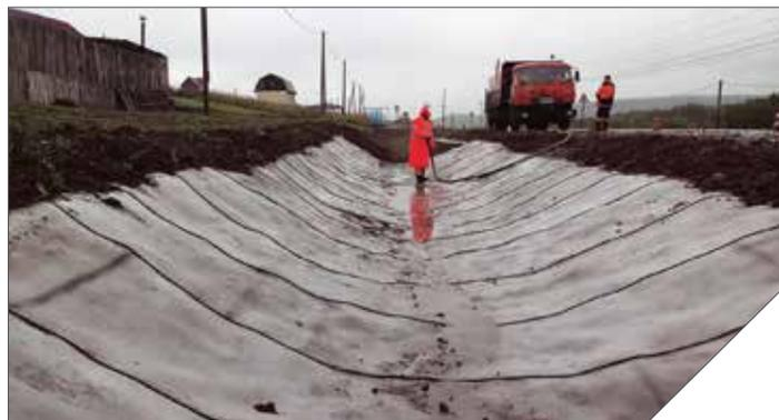
*Восстановление водоотводного кювета бетонным полотном, Красноярский край*
