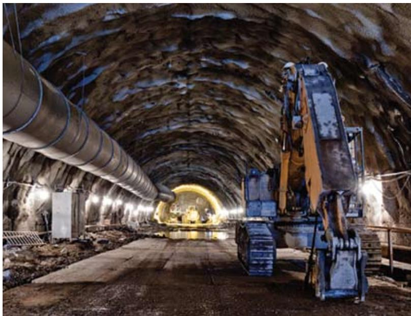
Проходка двухпутного железнодорожного тоннеля проектом предусмотрена способом нижнего уступа со стороны восточного портала с разработкой грунта в забое буровзрывным способом. Проходка калотты и нижнего уступа тоннеля производится последовательно. Проходка калотты осуществляется на всю длину тоннеля, затем проходится нижний уступ.
