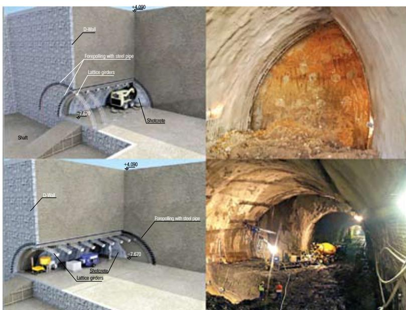
Рис. 4. Проходка калотты тоннеля с последовательной разработкой правой и левой штолен
