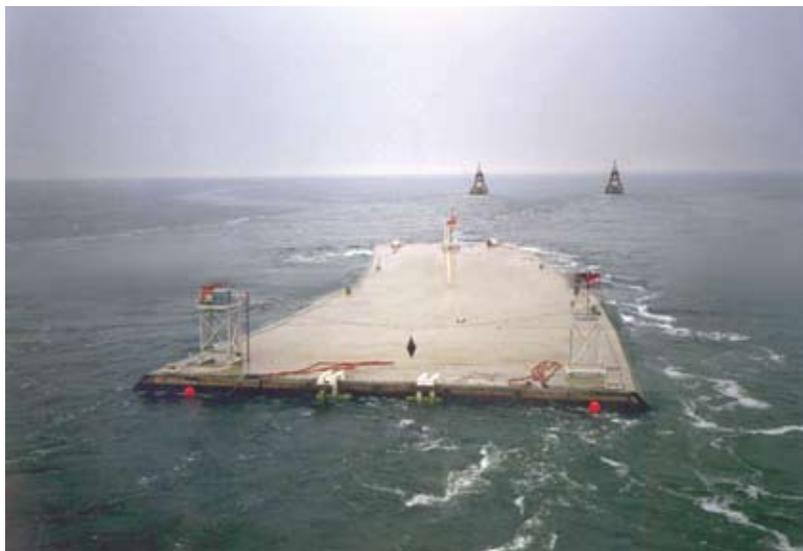
Рис. 8. Транспортировка железобетонной секции к месту погружения (Нидерланды)
