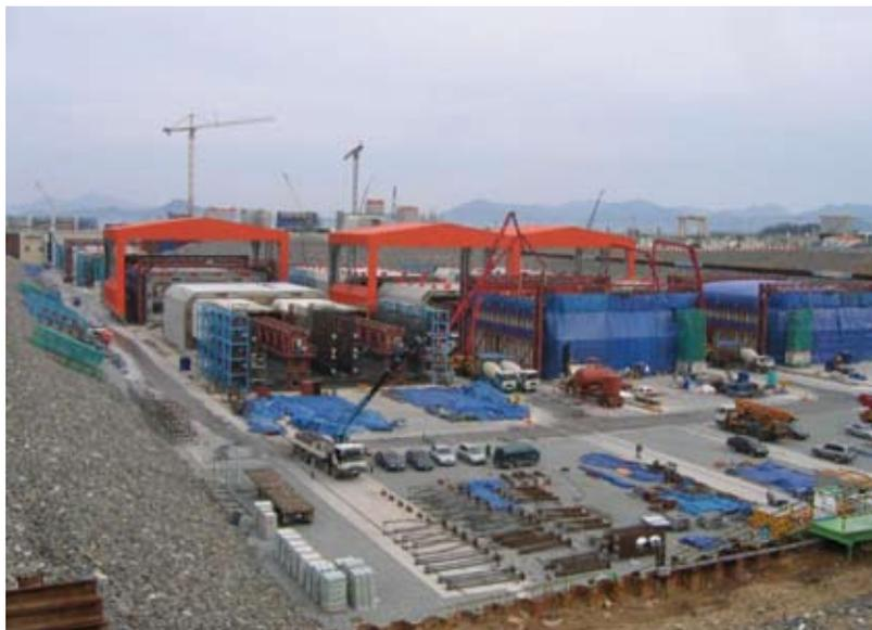
Рис. 7. Вид площадки для одновременной отливки нескольких секций тоннеля (западный берег залива Чинхэ (Jinphae) в Южной Корее)
