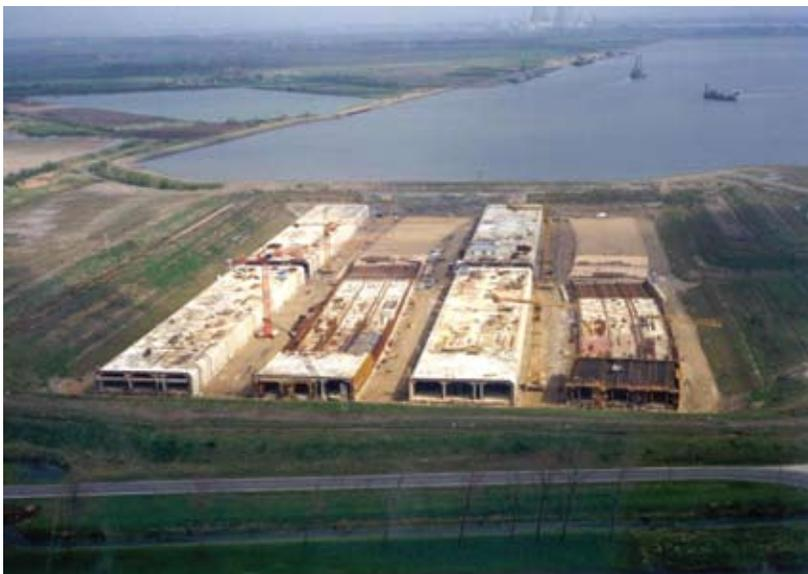
Рис. 6. Сооружение секций тоннелей в специальном котловане (Нидерланды)
