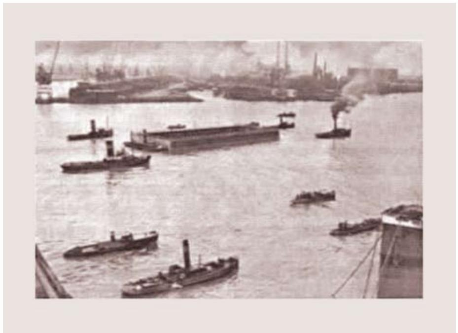
Рис. 9. Транспортировка секций Маасского тоннеля
