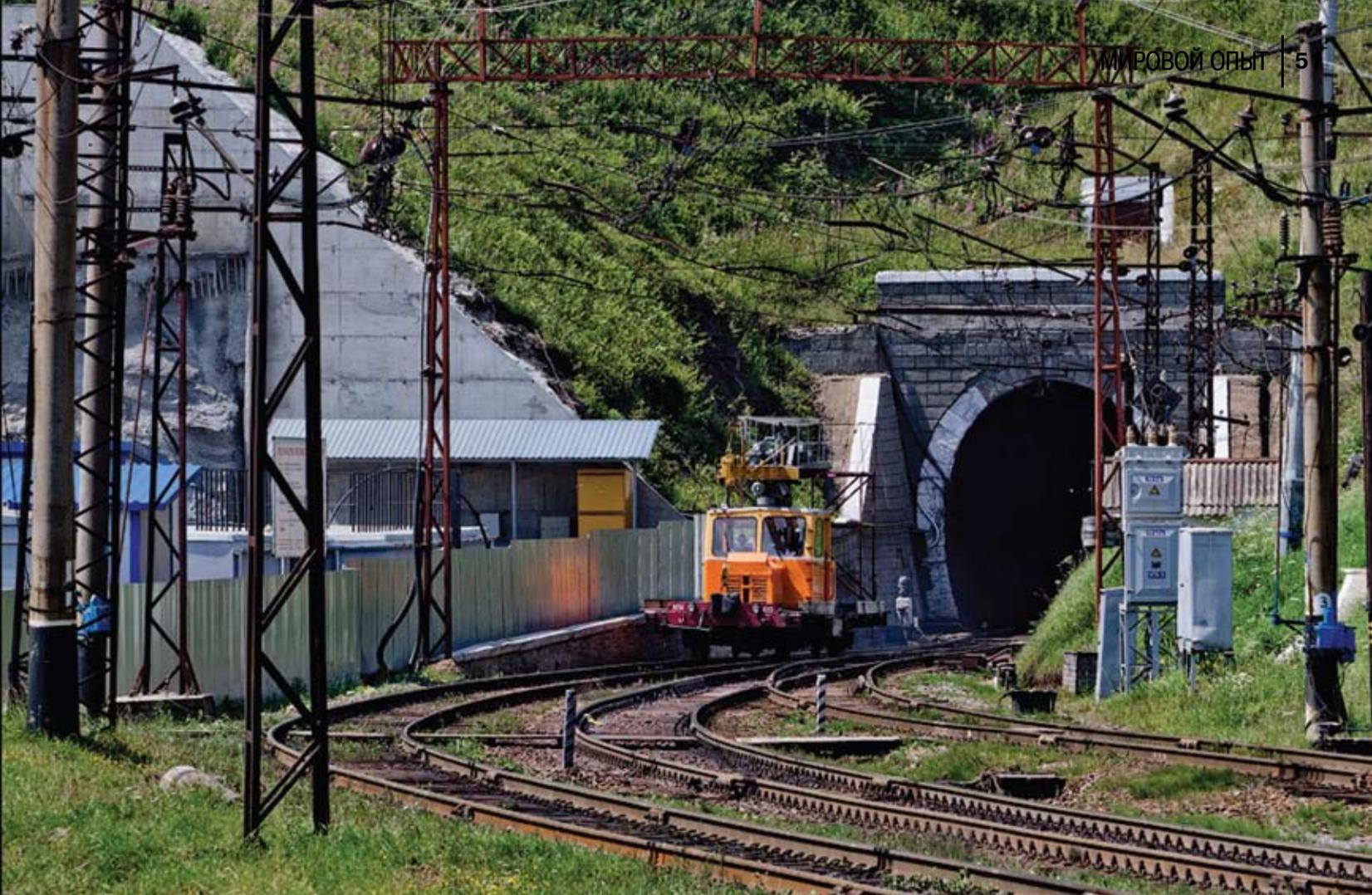
Наружное очертание всех типов обделок с целью оптимизации проходческих работ и унификации принято одинаковым. Конструкции обделок отличаются только процентом армирования, назначенным по результатам расчета, в зависимости от испытываемых нагрузок.
