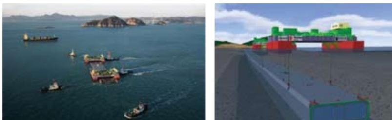
Рис. 10. Погружение секций со специальной баржи
