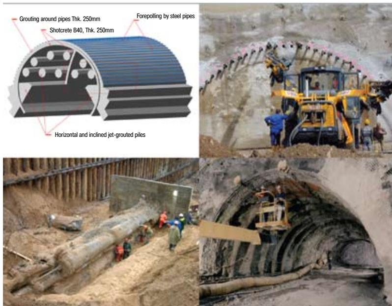
**Рис. 3. Опережающая крепь из экрана металлических труб и горизонтальных свай по методу струйной цементации с последующим креплением тоннеля решетчатыми фермами и набрызгбетоном**
