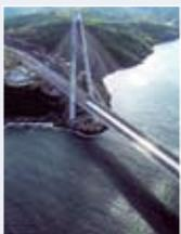
Магистраль длиной 142 км, соединяющая Одаери и Пашакой, включает в себя 6 тоннелей протяженностью более 3 км, 39 путепроводов совокупной протяженностью 15,7 км, а также 20 развязок. Ключевым сооружением объекта выступает мост султана Селима Явуза. Третий транспортный переход через пролив Босфор – самый широкий в мире вантово-висячий мост с самыми высокими пилонами.
