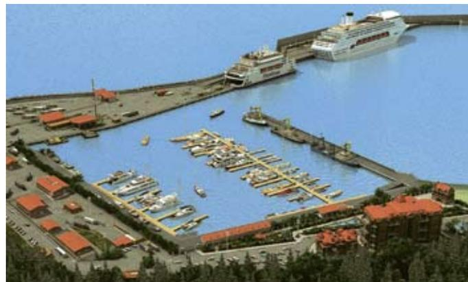
Для приема круизных лайнеров будут проведены дноуглубительные работы на участке акватории площадью в 30,5 га. В итоге глубина на входе в порт составит 10,9 м, тогда как сейчас она равняется 5–6 м. В процессе дноуглубительных работ планируется извлечь около 1,2 млн. м<sup>3</sup> грунта.
