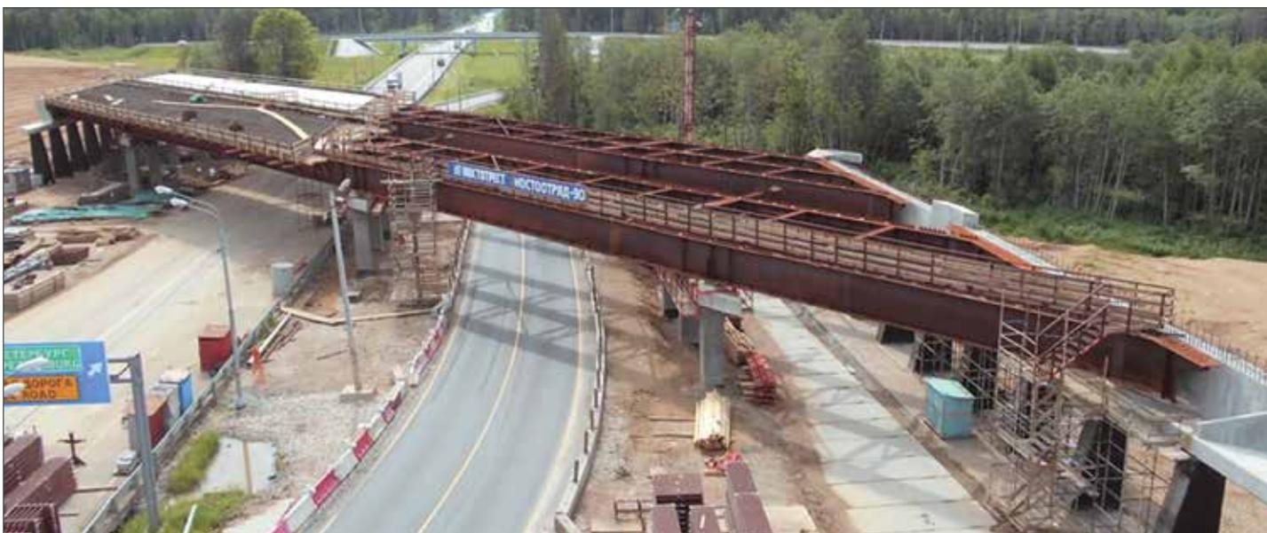
Рис. 1. Монтаж пролетных строений путепровода на ПК 2565+44,29 автомобильной дороги М-11 «Нева» (из фототеки ООО «Автодор-Инжиниринг»)
