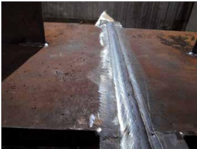
Рис. 3. Монтажный шов, промежуточный этап. Путьпровод на ПК 2565+44,29 автомобильной дороги М-11 «Нева» (из фототеки ООО «Автодор-Инжиниринг»)
