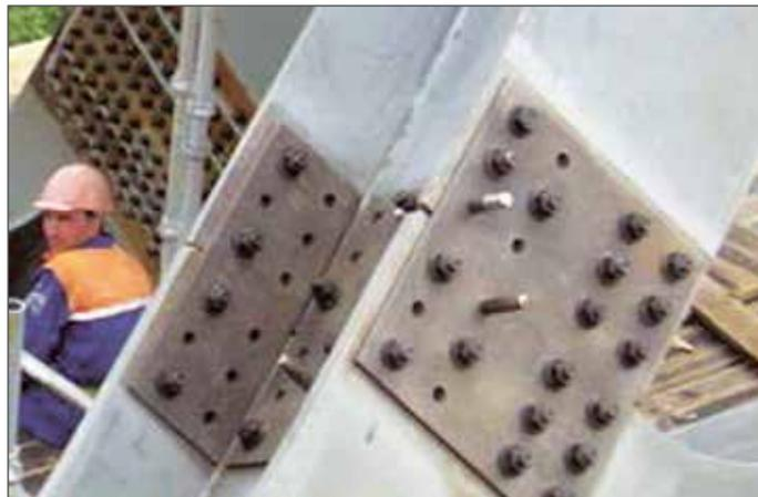
■ клеефрикционные покрытия на основе эпоксидных и полиуретановых материалов с фрикционными добавками, наносимые на одну из поверхностей.
