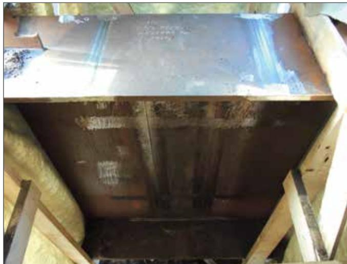
Рис. 4. Монтажный шов. Путьпровод на ПК 2565+44,29 автомобильной дороги М-11 «Нева» (из фототеки ООО «Автодор-Инжиниринг»)
