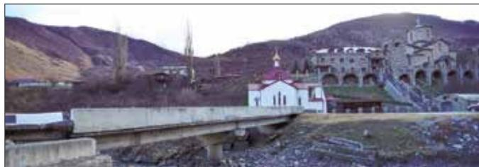
новых опор и пролетных строений, прокладку мостового полотна, устройство многослойной дорожной одежды и новых деформационных швов, компенсирующих воздействие расчетных температурных деформаций и плавность проезда. Кроме того, здесь восстановят водоотвод, отремонтируют подпорную стену под мостом и выполнят иные необходимые работы.
