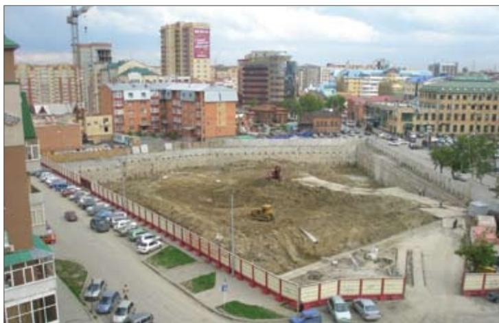
Рис. 4. Устройство подземной части автомобильной стоянки по технологии «стена в грунте» (Тюмень)
