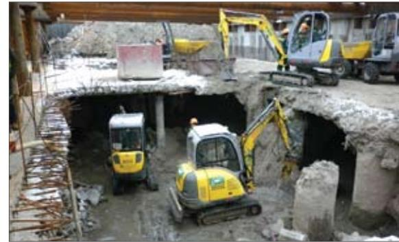
Рис. 5. Разработка грунта при строительстве методом «сверху–вниз»
