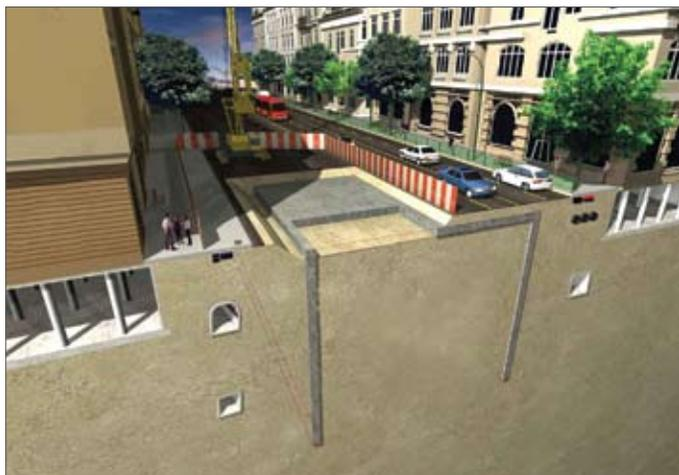
Рис. 5. III этап – перенос движения, сооружение второй стены в грунте и второй части плиты покрытия
