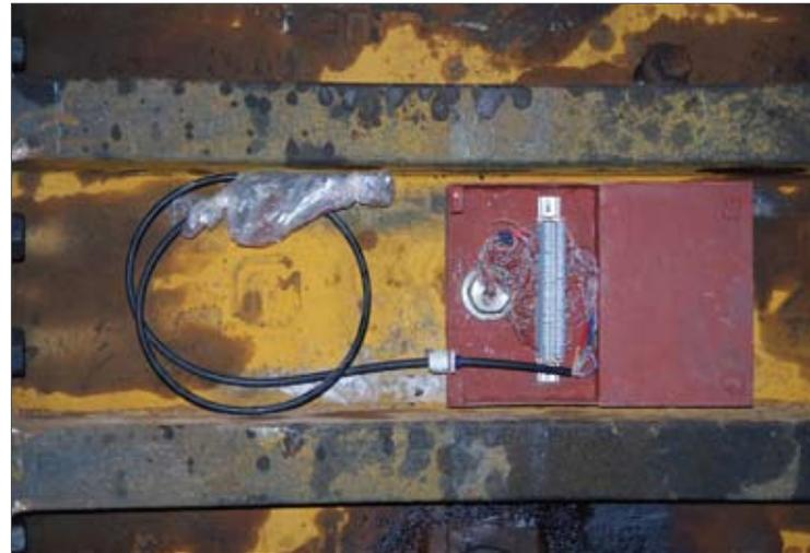
Рис. 9. Размещение клеммного щитка и выводного кабеля в кассоне тубинга
