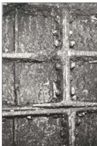
Рис. 6. Характер разрушения тубингов
