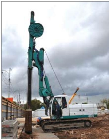
Рис. 3. Машины для производства работ по технологии «стена в грунте»: гидрофреза и телескопический грейфер
