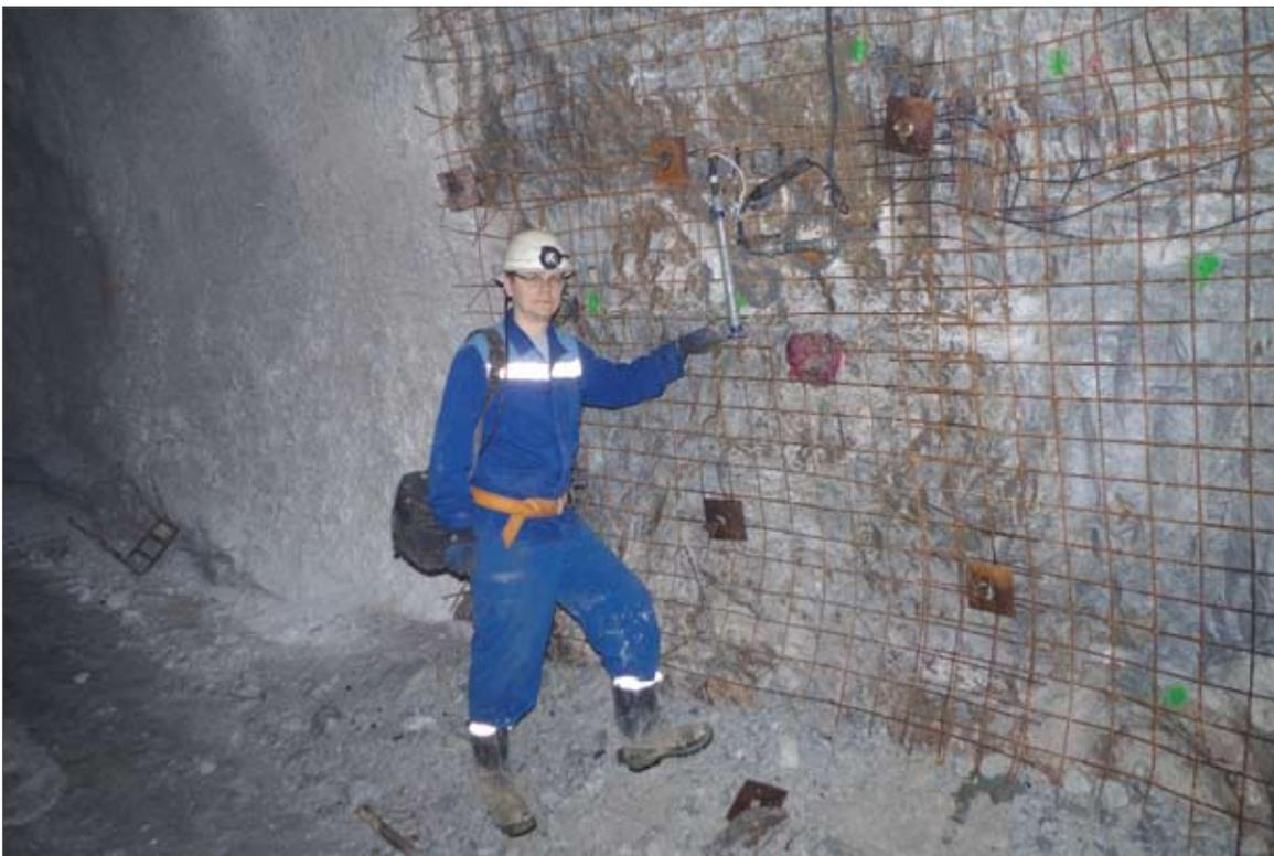
Рис. 11. Установка приборов в торкрет-бетонной крепи выработок
