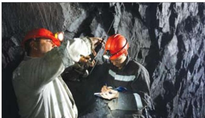
Рис. 4. Измерения смещений по наклонным базам
