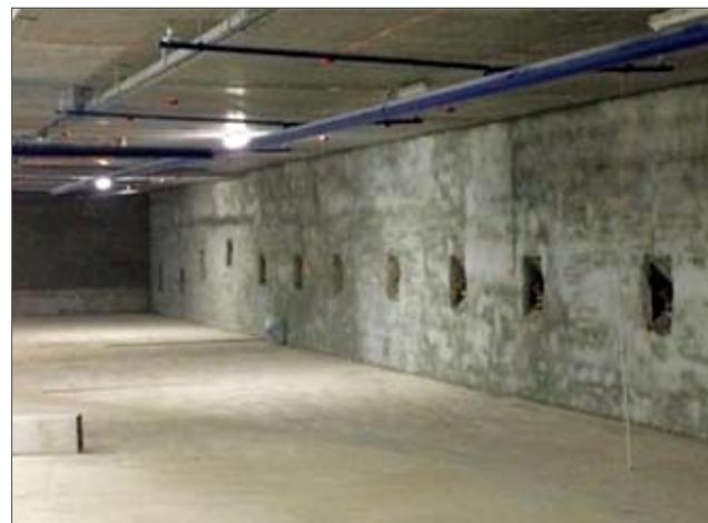
Рис. 5. Подземная стоянка, огражденная конструкциями, выполненными по технологии «стена в грунте»
