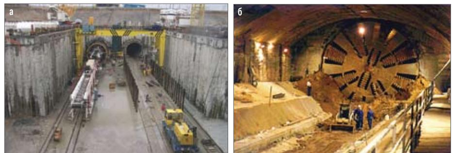
Рис. 2. Щитовая проходка двух однопутных (а) и одного двухпутного (б) тоннелей
