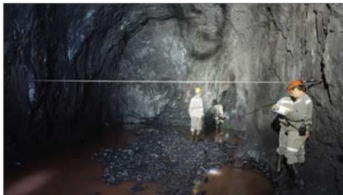
Рис. 5. Измерения смещений по горизонтальным базам
