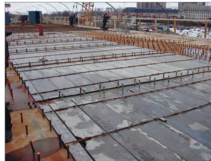
Рис. 2. Элементы несъемной тонкостенной опалубки при строительстве эстакады на Западном скоростном диаметре в Санкт-Петербурге
