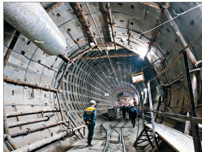
Строительство Лахтинско-Правобережной линии. Источник: metrostroy-spb.ru
