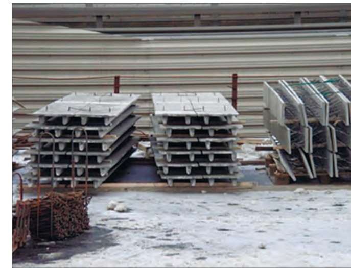
Рис. 2. Элементы несъемной тонкостенной опалубки при строительстве эстакады на Западном скоростном диаметре в Санкт-Петербурге
