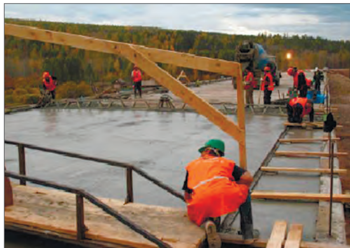
Рис. 1. Опыт укладки сталефибробетона на объекте ЗАО «Сибмост-45» севернее Иркутска на реке Лене в сентябре 2009 года ( http://www.wolwekplus.ru )
