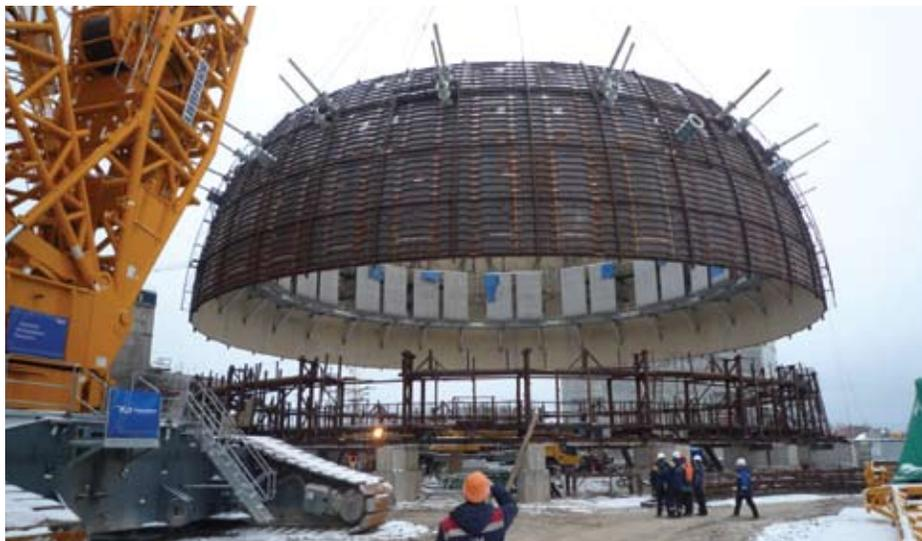
бетоне установлены каналобразователи, в которые заведены «арматурные пучки» из стальных канатов. По завершению бетонирования оболочки, канаты натягиваются, таким способом оболочка обжимается, набирая проектную жесткость и прочность.
