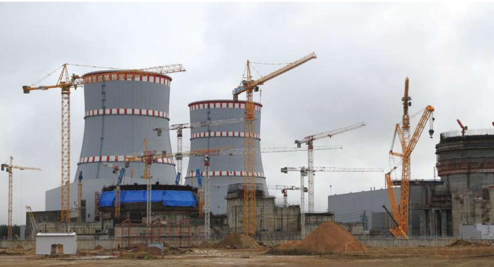
ту и 120 м в диаметре каждая. На сооружение такой градирни потребовалось более полу-миллиона кубометров бетона. В этот период куски «атомного пирога» помимо ЗАО «СМУ №13 Метрострой», поделили ЗАО «Тоннельный отряд — 3» и ЗАО «Компакт», ведущие строительные организации Метростроя.
