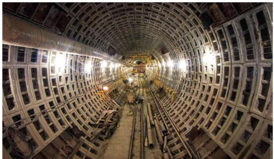
вестибюль. Сейчас мы снизу вверх поднимаем постоянную конструкцию, возводим монолитное крепление.
