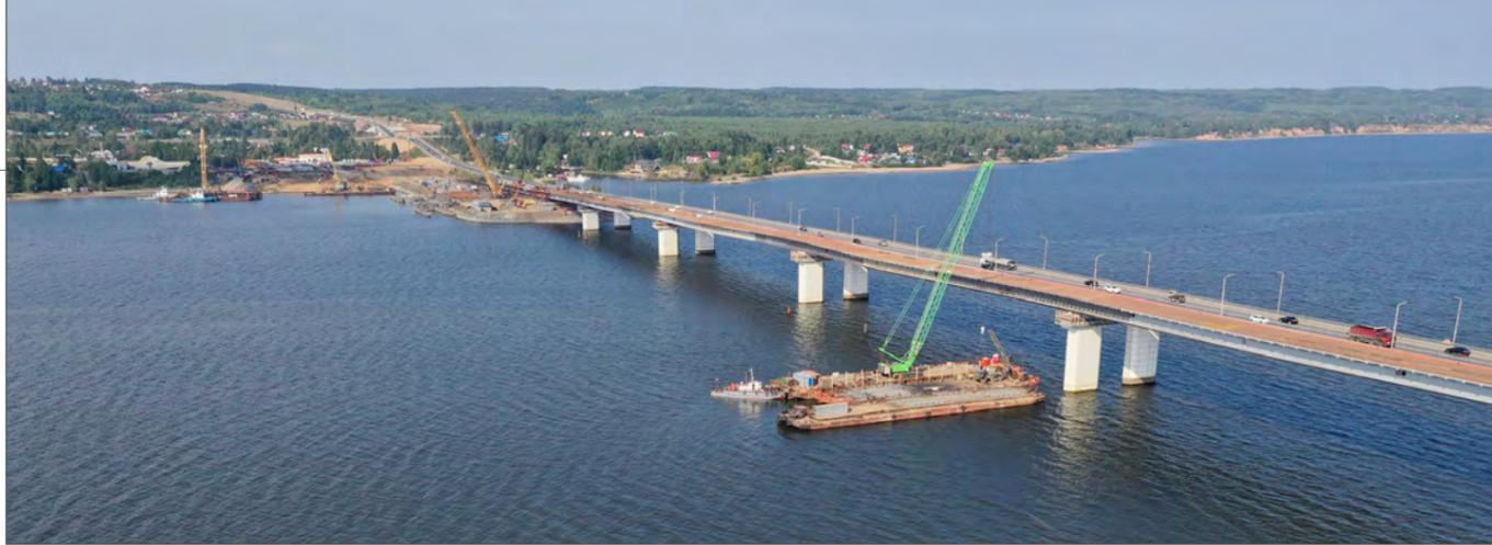
крупногабаритные конструкции, требовалось добиться его несущей способности до 200 т на одну сваю. С этой трудоемкой работой строители успешно справились. Непростой задачей было ведение работ с воды. Для этого тяжелые краны помещали на баржи. Для обеспечения равномерности нагрузки, остойчивости судна, необходимой его осадки, показателей прочности разрабатывались специальные проекты обустройства барж, проводились соответствующие расчеты с последующим согласованием в профильных ведомствах.
