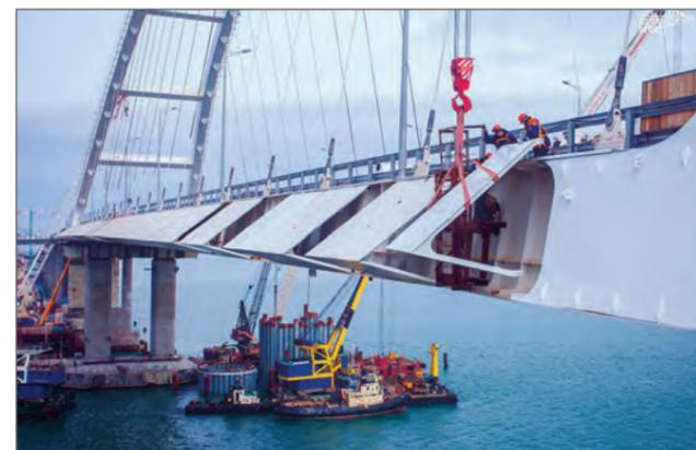
Рис. 5. Монтаж обтекателя, разработанного в Крыловском центре, для пролетного строения Крымского моста
