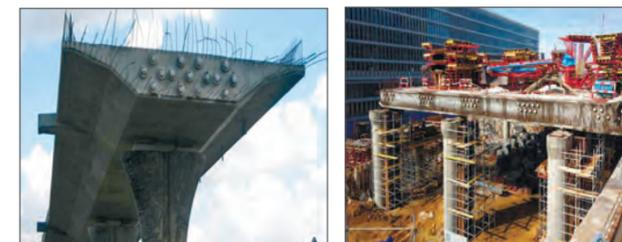
Плитно-ребристые конструкции (ПРК) и плитные пролеты с СПН
