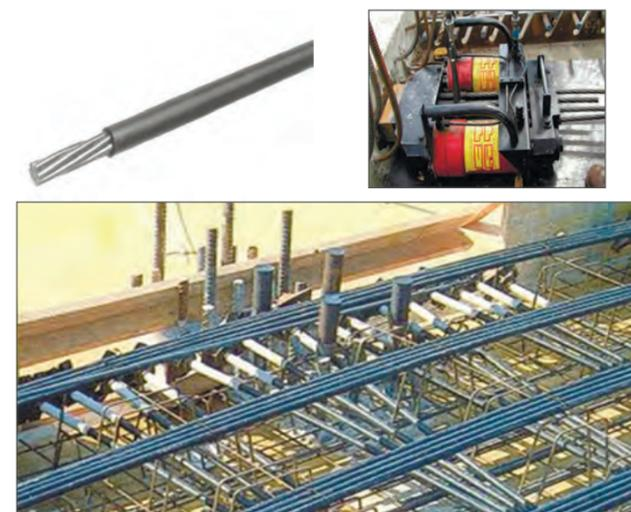
СПН по методу без сцепления с бетоном. Инъекция не требуется. Натяжение на бетон
