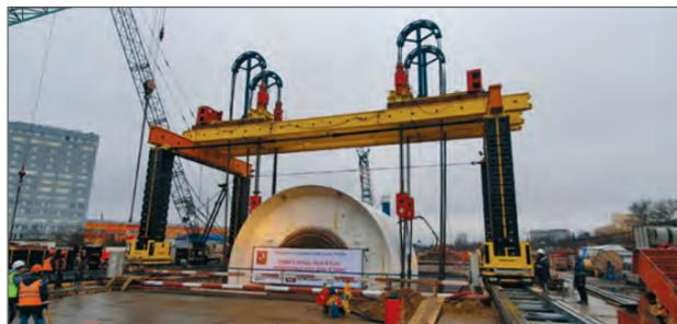
литена. За счет параллельного выполнения операций по сборке/разборке и подготовке площадки и котлована сроки производства работ сократились в два раза. Были выполнены: подъем частей тоннелепроходческого комплекса (ТПМК) из тоннеля; сборка механизированного щита на поверхности с дальнейшим опусканием агрегата (масса 740 т) на 25 м ниже уровня земли.
