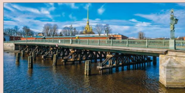
крепостью через Кронверкский пролив. В 1950–1951 гг. исторический объект подвергся масштабной реконструкции. Сейчас это семипролетное деревянное сооружение с металлическим пролетным строением длиной 74,66 м и шириной 10,54 м на деревянных русловых опорах с каменными аркадами. Мост находится под охраной Комитета по государственному контролю, использованию и охране памятников истории и культуры Санкт-Петербурга.
