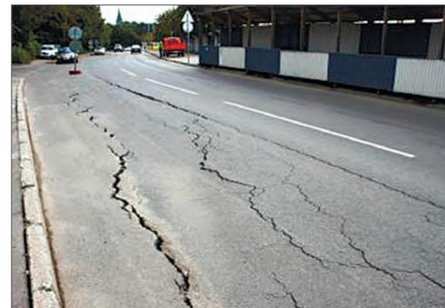
Рис. 2. Дефекты проезжей части мостовых сооружений
