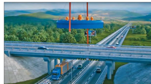
Рис. 2. Габариты под дорогой верхнего уровня и габарит широкоформатного груза
