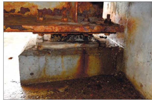
Рис. 5. Дефекты в конструкциях мостов, возникающие от различных воздействий из-за нарушения системы защиты и водоотведения
