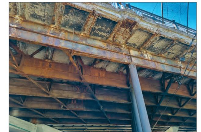
Рис. 1. Дефекты в несущих конструкциях мостов из-за нарушений в работе дорожной одежды и системе водоотведения
