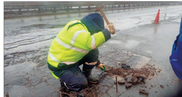
Рис. 7. Разрушение покрытия на путепроводе на км 53+800 а/д М-7 «Волга» в Московской области (направление в область), через год после ремонта
