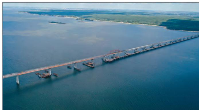
ли возводить одновременно с обеих сторон реки. Глубина Волги в самых крупных выемках здесь достигает 19 м. Полная высота опор составляет 50 м — почти как 16-этажный (!) дом, — а от уровня воды сооружение поднято на 37 м.
