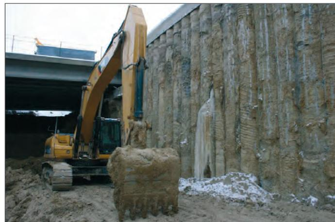
Рис. 9. Типовой дефект стенки из буросекущих свай — отсутствие герметичности
