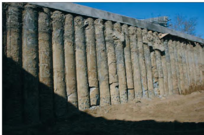
Рис. 10. Общий вид дефектной стенки из буроэкующих свай перед ремонтом
