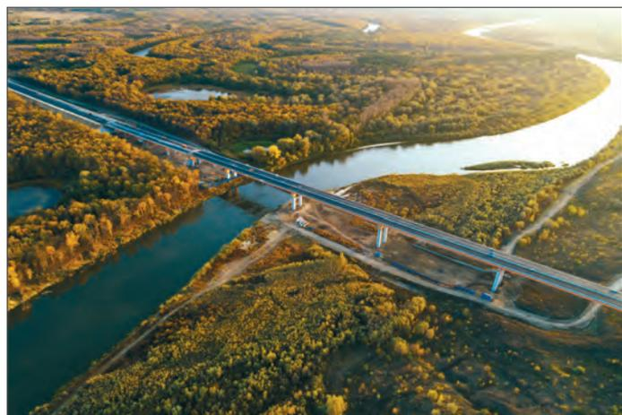
сборкой. Всего мост расположен на 11 опорах. Протяженность переправы — 930,5 м, а общий вес металлоконструкций — порядка 10 тыс. т.
