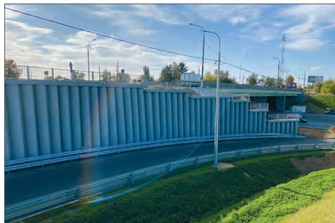
Рис. 12. Устройство подпорной стенки из трубошпунта
