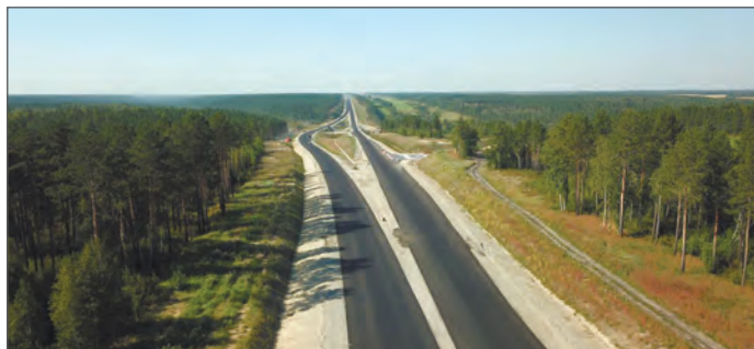
Строительство обхода Усоля-Сибирского, Иркутская область
