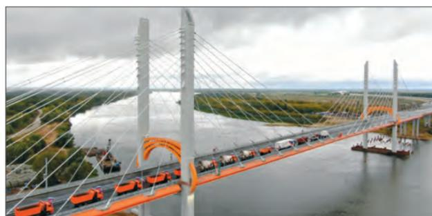
графическому стилю ГК «Автодор». Элементы перемычки между стойками пилонов создают образ «портала» в форме эллипса, сквозь который двигаются автомобили.
