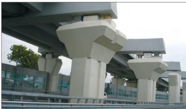
Рис. 6. Сейсмозащитные устройства на эстакаде ж.д. Адлер – Красная Поляна
