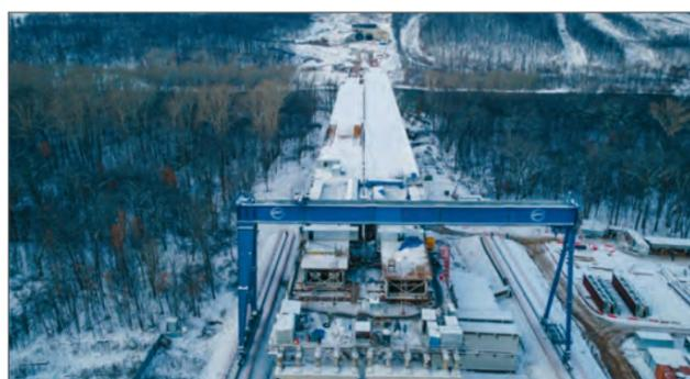
Рис. 6. Укрупнительная сборка главных балок пролетного строения через реку Уфу
