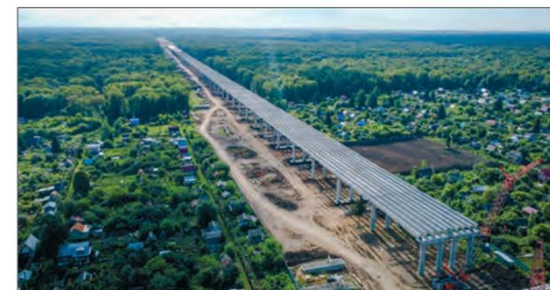
Рис. 4. Строительство эстакадного участка мостового перехода через реку Уфу
