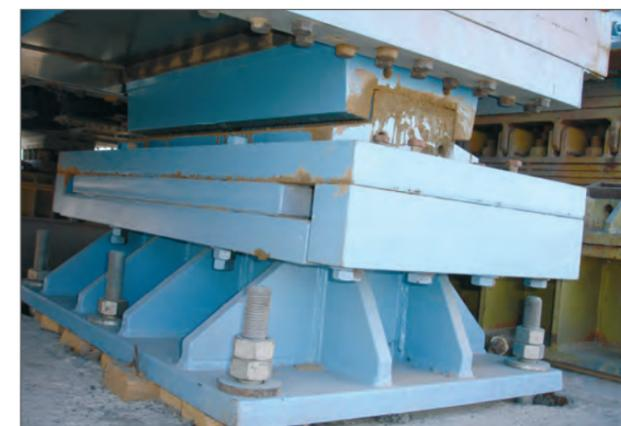
Рис. 5 Сейсмостойкая опорная часть на мосту в Туркмении
