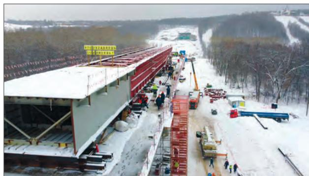
Рис. 5. Надвигка пролетного строения через реку Уфу
