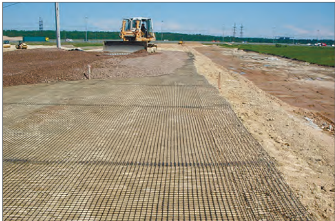
Рис. 4. Устройство армирующего слоя из геосетки со щебнем
