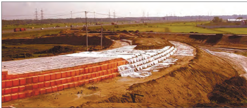
Рис. 3. Уложенный участок облегченной насыпи и заливка пенобетона между блоками
