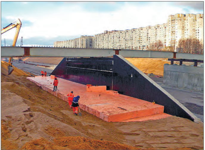
Рис. 6. Устройство облегченной насыпи при строительстве путепровода через Богатырский просп. в Санкт-Петербурге
