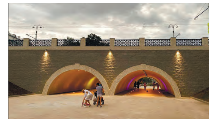
Реконструкция моста через р. Лыбедь на ул. Ленина в Рязани
