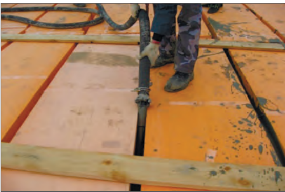
Рис. 3. Уложенный участок облегченной насыпи и заливка пенобетона между блоками
