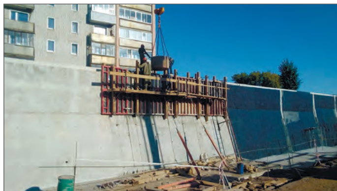
Устройство подпорных стенок на объекте «Путепровод с реконструкцией ул. И. Попова от ул. Щорса до ул. Чистопрудненской в г. Кирове»
