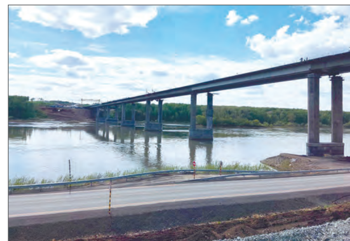
Завершающая надвигка моста «Звездный», входящего в состав Северо-Западного обхода Кемерово.
