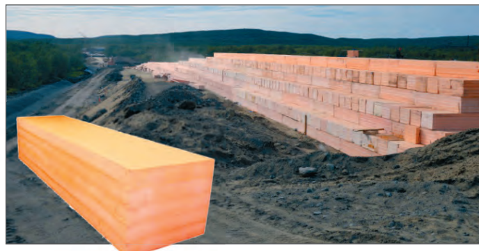
Рис. 7. Блок из экструзионного пенополистирола и строительство дороги из таких блоков
