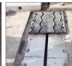
Рис. 5. Смонтированный модуль деформационного шва
