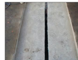
Рис. 4. Подготовленная поверхность для устройства деформационного шва
