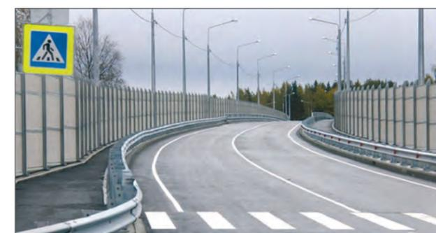
Для обеспечения пешеходной связи предусмотрено устройство лестничных сходов и тротуаров. На сооружении установят наружное стационарное освещение, которого не было ранее, и освещение проходов для маломерных судов.
