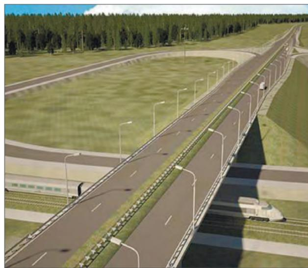
Рис. 4. Двухуровневая транспортная развязка по типу «неполный клеверный лист»
