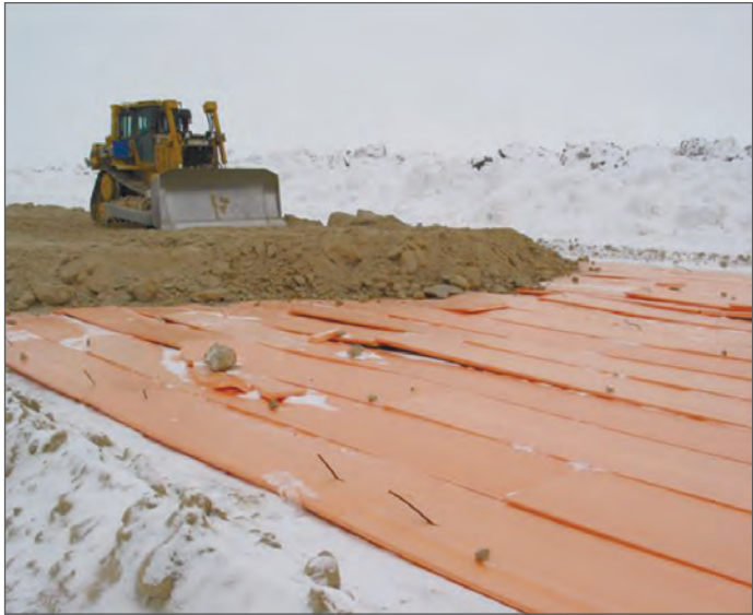
Рис. 6. Устройство теплоизоляционного слоя из плит «Пеноплэкс»
