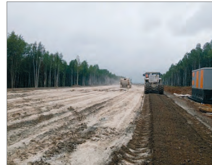
Рис. 2. Смешивание грунта с вяжущим материалом
