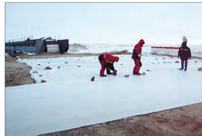
Рис. 2. Устройство геообойм из геотекстиля на подходе к мосту
