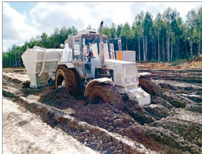
Рис. 1. Распределение негашеной извести по переувлажненному грунту
