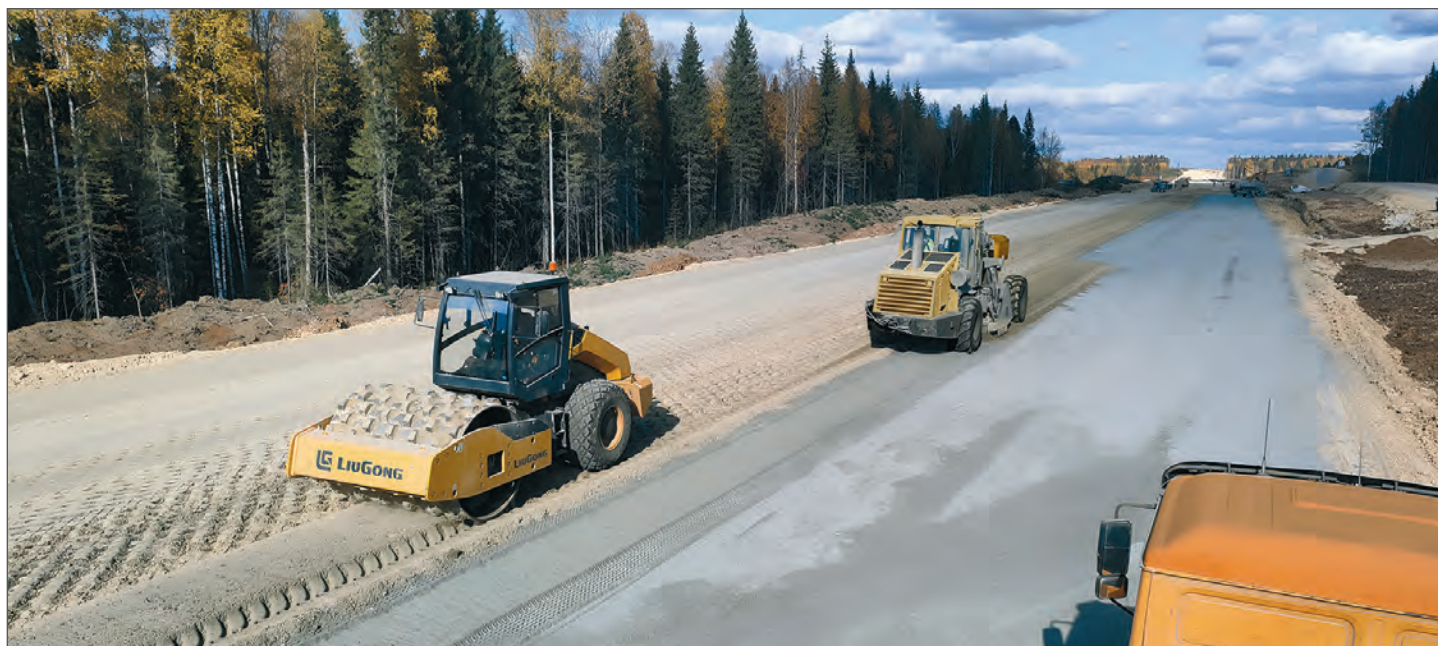
Рис. 3. Обжим грунта грунтовым катком с бандажом
