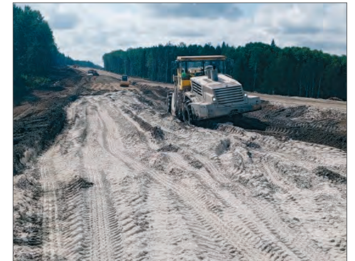
Рис. 2. Смешивание грунта с вяжущим материалом
