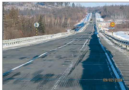
Рис. 1. Дефекты асфальтобетонного покрытия на автомобильной дороге Р-297 «Амур»
