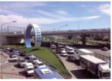
Транспортная развязка «Адлерское кольцо» (г. Сочи). Антикоррозионная защита металлоконструкций: ЦИНОТАН + ПОЛИТОН-УР + ПОЛИТОН-УР(УФ). Антикоррозионная защита железобетонных конструкций: ФЕРРОТАН-ПРО + ПОЛИТОН-УР + + ПОЛИТОН-УР (УФ)
