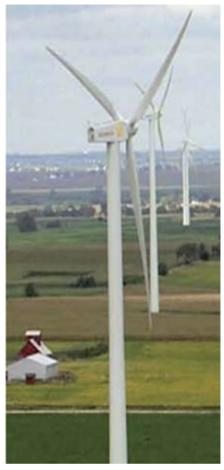
Проектом реконструкции автодороги М-4 «Дон» км 1024 — км 1091 предусматривается строительство двух ветроэлектростанций (ВЗС) мощностью 4,25 и 2,55 МВт каждая, соответственно с 5 и 3 ветроэнергетическими установками (ВЗУ) единичной мощностью по 850 кВт.
