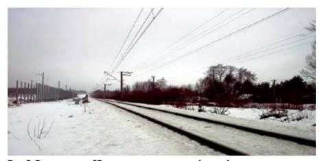
Рис. 2. Строительство АЗ между существующими (справа) и строящимися (слева за строящимся АЗ) путями железной дороги, ст. Лосево, Ленинградская область (справа — защищаемое от шума садоводство)
