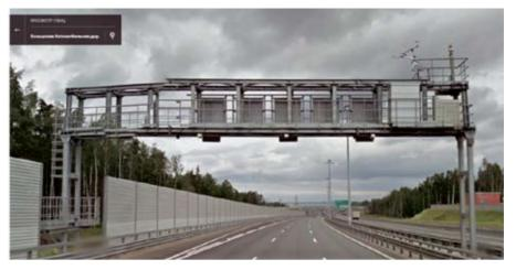
Рис. 1. Некорректное совмещение транспортного АЗ и опоры АСУДД (разрыв в экране)
