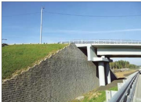
Рис. 5. Укрепление конуса моста с помощью Системы Макволл
