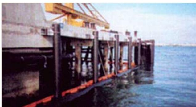
Рис. 4. Полимерные сваи на пирсе Браво (база ВМС США в Сан-Диего)
