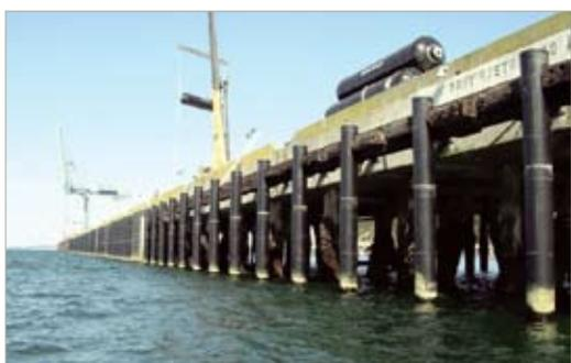
Рис. 5. Полимерные сваи в Порт-Хэдлоке (объект ВМС США)
