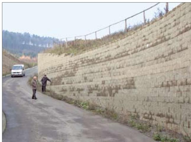
Рис. 5. «Плачущие стены»: темные пятна от протечек воды (Чехия)
