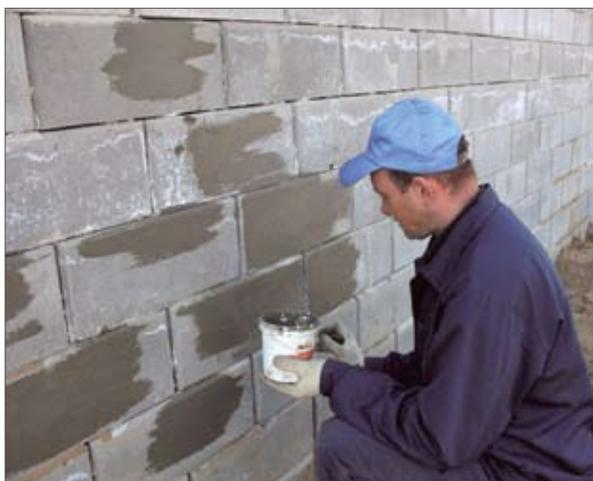
Рис. 4. «Плачущие стены»: проступившая вместе с протечками воды соль из морского песка; рабочий закрашивает следы соли цементным молоком
