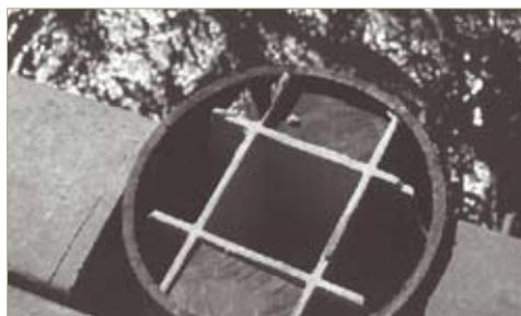
Рис. 3. Полимерная свая конструкции Creative Pultrusions, установленная в рамках программы CPAR на пирсе Tiffany Street Pier
