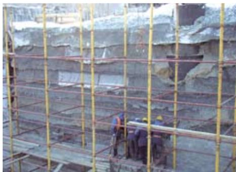
Рис.1. Разобранная армогрунтовая стена во Владивостоке
