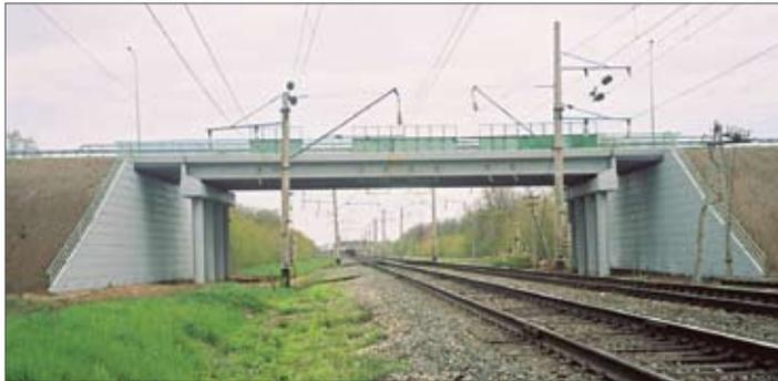
Рис. 3. Общий вид готового путепровода с устоями с раздельными функциями (Чувашия, авто-трасса «Аниш»)
