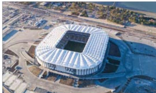
Проект получил положительное заключение ФАУ «Главгосэкспертиза России» 26 ноября 2015 года. Размещение стадиона определено в соответствии с генеральным планом Ростова-на-Дону на левом берегу Дона. Объект возводился на крайне сложном грунте из-за непосредственной близости реки. Для создания площадки строительства намывался слой песка высотой около 6 м.
