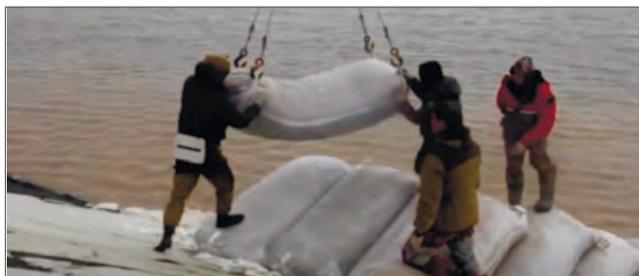
Рис. 1. Укрепление берега реки с применением геоконтейнеров
