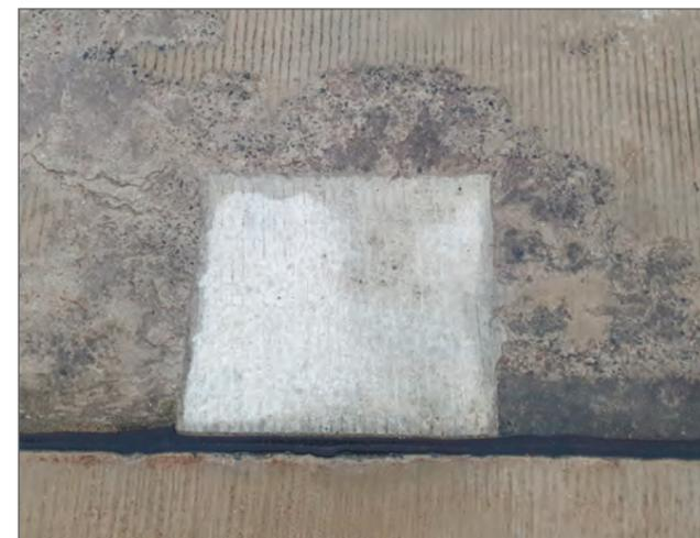
Рис. 1. Начальная стадия разрушений соприкасающегося цементобетона (перрон одного из аэропортов МАУ)
