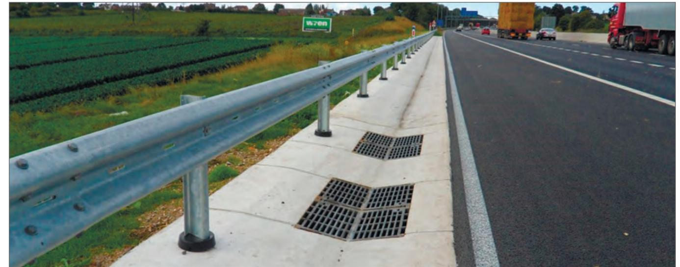
Затем — или по бетонным телескопическим лоткам по откосу насыпи в водоотводную канаву с устройством гасителей (вне пределов водоохранных зон), или в систему ливневой канализации и локальные очистные сооружения посредством дождеприемных колодцев.
